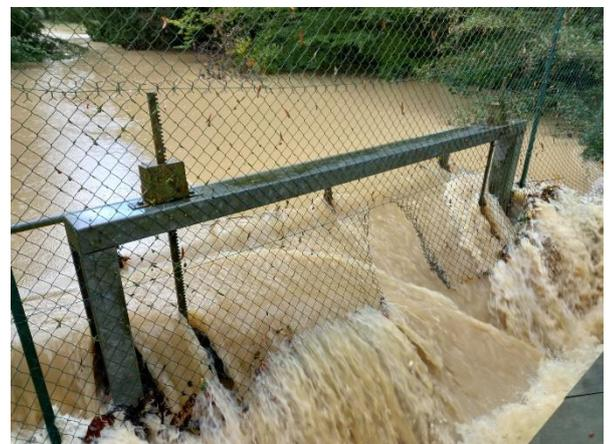
*La Rémarde en surverse au niveau des vannes du château d'Esclimont, maintenues en position fermée pour favoriser la rétention des eaux en amont*
