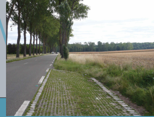
Sol perméable (Magny)
