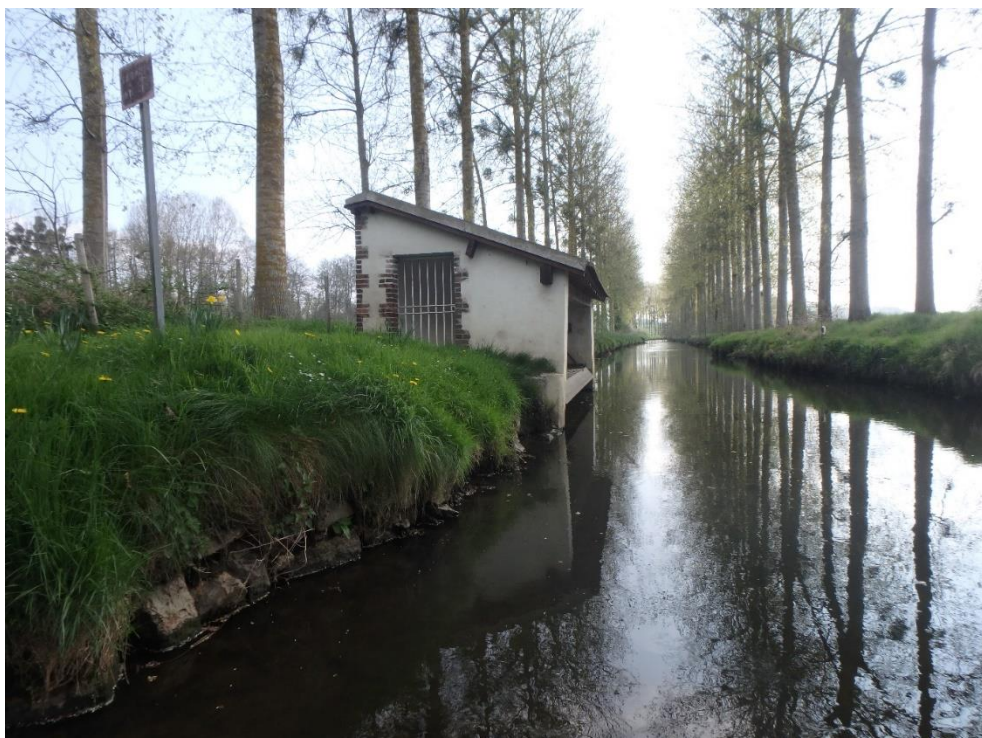
Figure 7: Exemple d'un tronçon recalibré ; la Drouette à Saint Martin de Nigelles (28)
