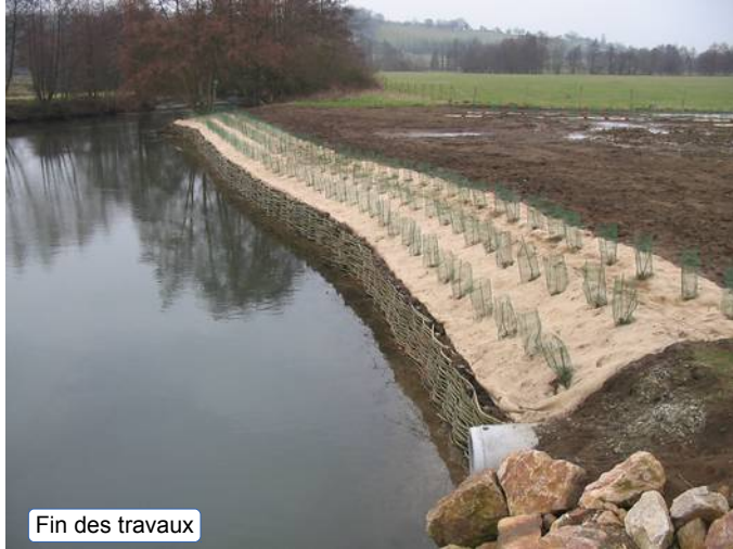
Protection des berges par végétalisation Travaux sur l'Huisne, source photo : CD 28
