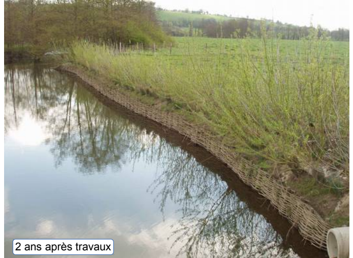
Protection des berges par végétalisation Travaux sur l'Huisne, source photo : CD 28
