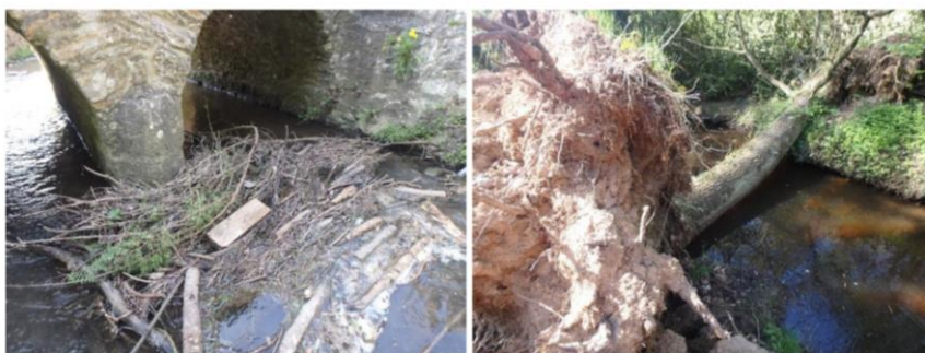
Figure 29 Illustration d'embâcles problématiques constatés sur le bassin versant de la Drouette
