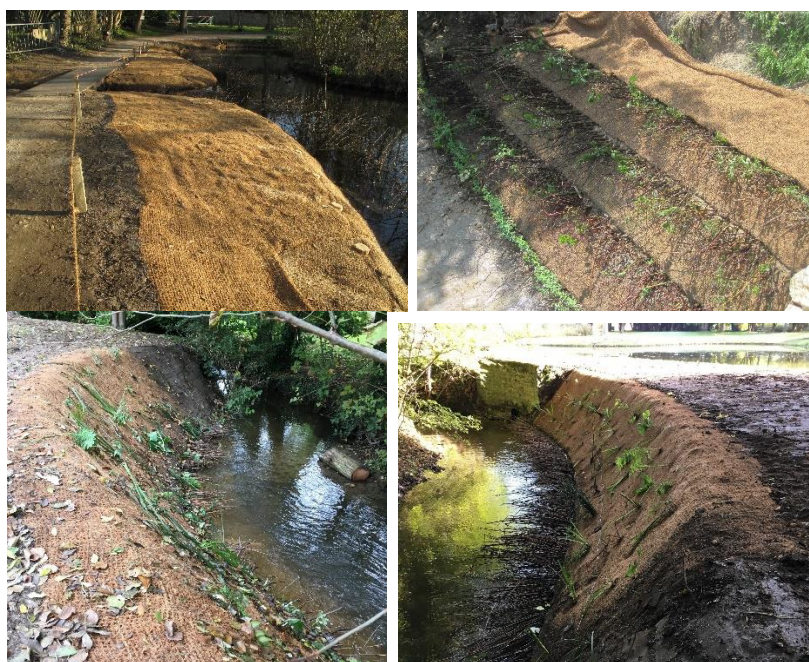
Figure 6 : Photos de reprises de berges avec différentes techniques issues du génie végétal (Source : N. Brault)
