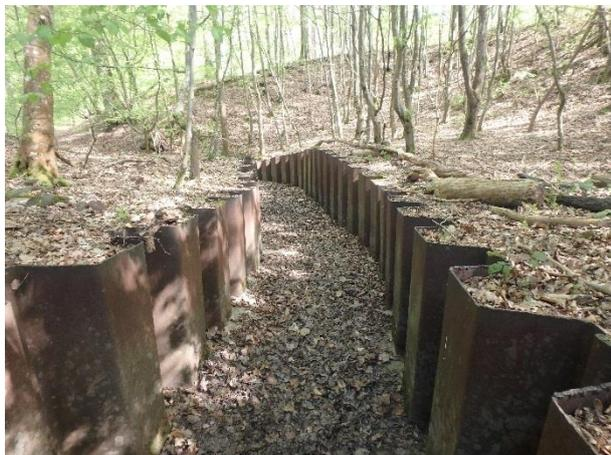
**Photo 22 : Photo de palplanche métallique sur le ru du Coupe Gorge (printemps 2017)**
