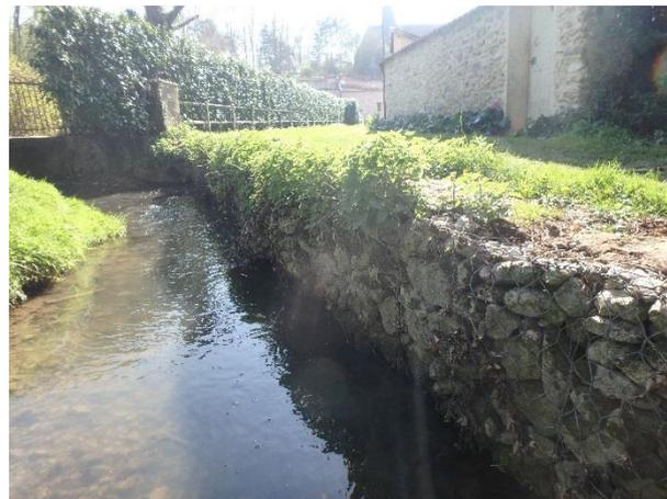
**Photo 23 : Photo de Gabions sur la Drouette (printemps 2017)**
