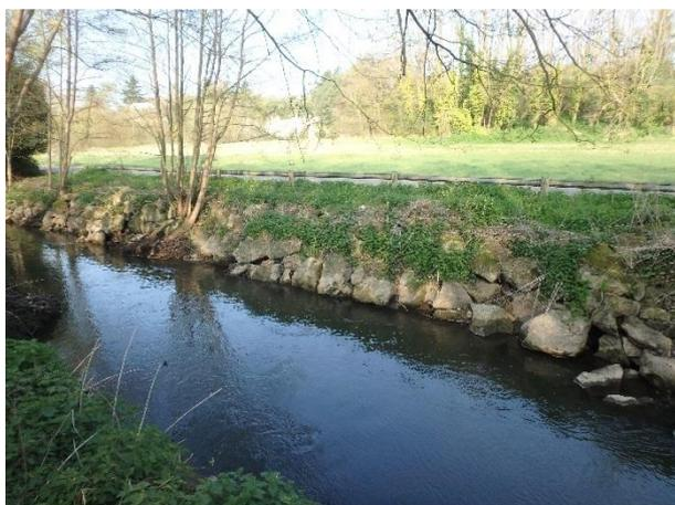
**Photo 24 : Photo d'enrochements libres sur la Drouette (printemps 2017)**
