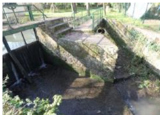
Vue aval du vannage de la Palombe
