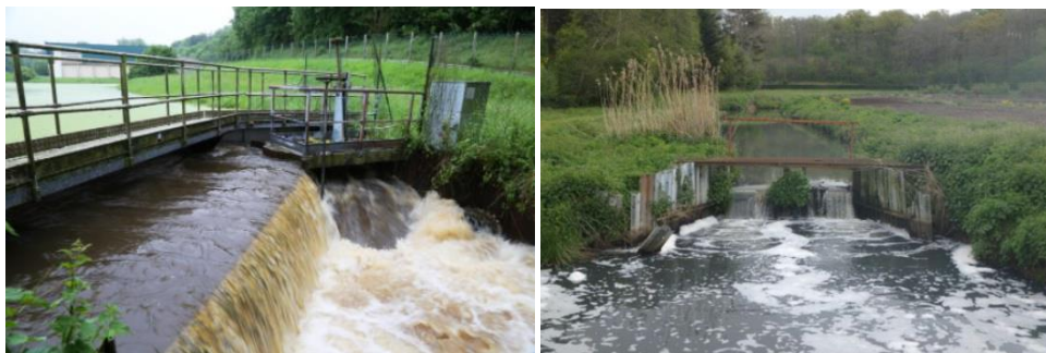
Ouvrages liés à la station d'épuration de Gazeran (78) et bloquant la continuité écologique sur la Guéville
