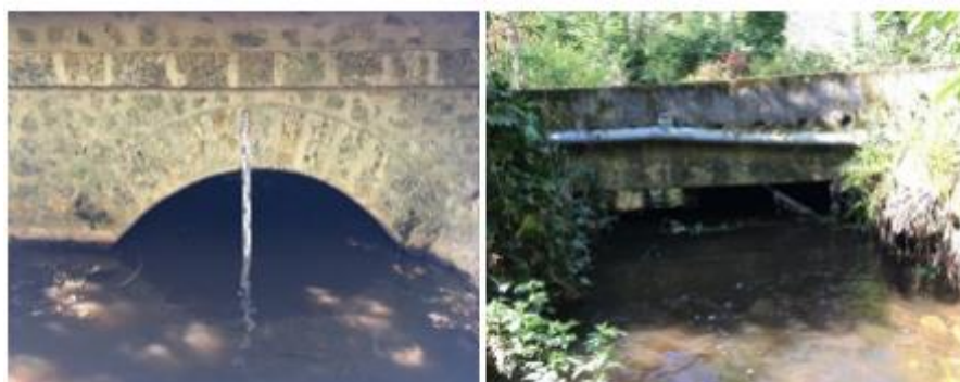
Succession de ponts sous-dimensionnés dans le centre-bourg de Poigny-la-Forêt (78)
