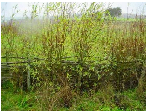
Fascine en bois vivant (source : SBV de l'Yères et de la Côte)
