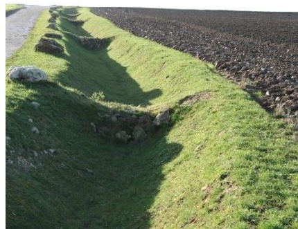
Fossés d'infiltration à redents naturels, en terre (à gauche) et en pierres sèches (à droite)
