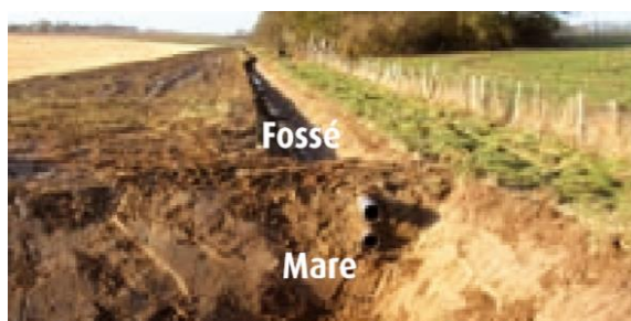
Mare tampon créée à l'exutoire d'un fossé de drainage
