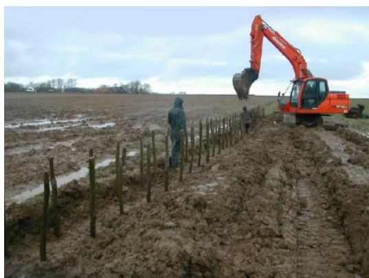
Battage des pieux (source : SMBV Pointe de Caux)
