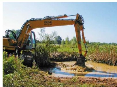
Curage mécanique
