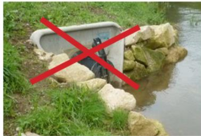
Mauvais exemple de rejet en berge
