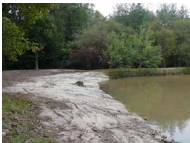
Reprofilage d'une berge en pente douce (source : CRPF 36)
