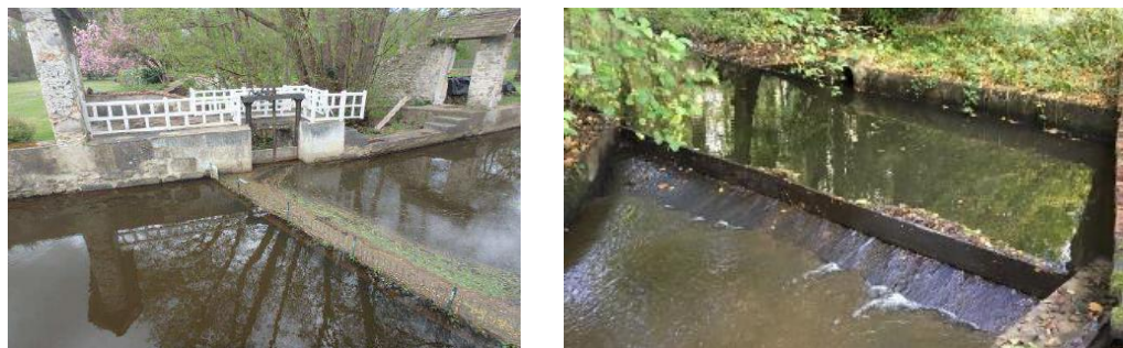
Ouvrage répartiteur lié au moulin de Raizeux (78)
