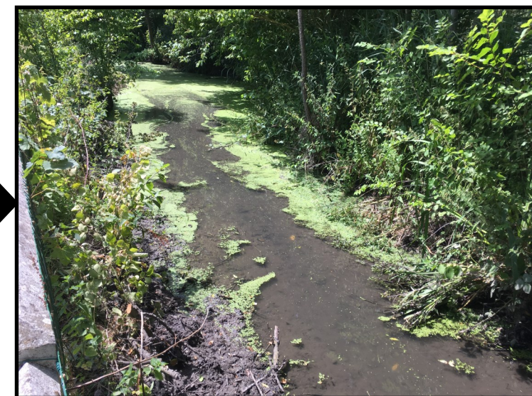
Après intervention / chenal redimensionné et écoulement restauré
