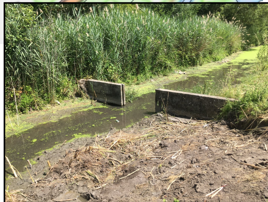
Après intervention / chenal redimensionné et écoulement restauré
