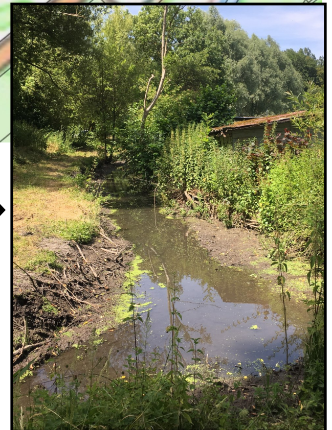
Après intervention / chenal redimensionné et écoulement restauré
