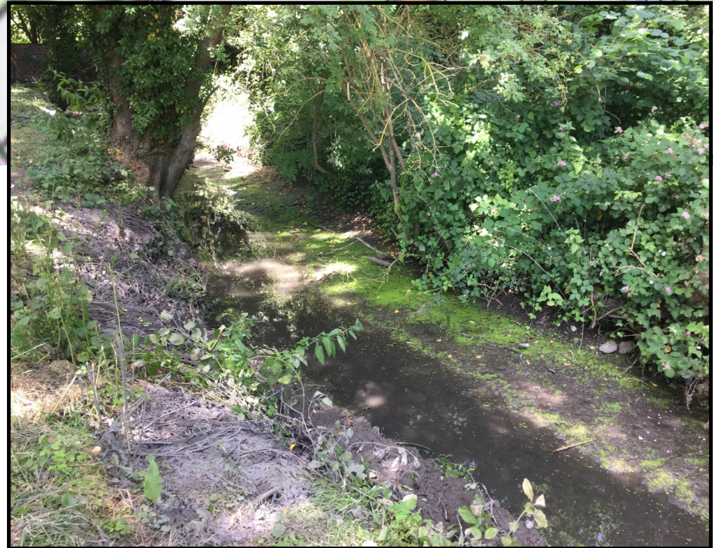
Après intervention / embâcles retirés, chenal redimensionné et écoulement restauré
