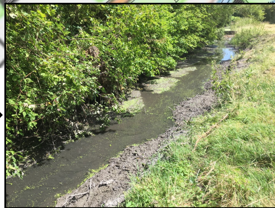
Après intervention / chenal redimensionné et écoulement restauré
