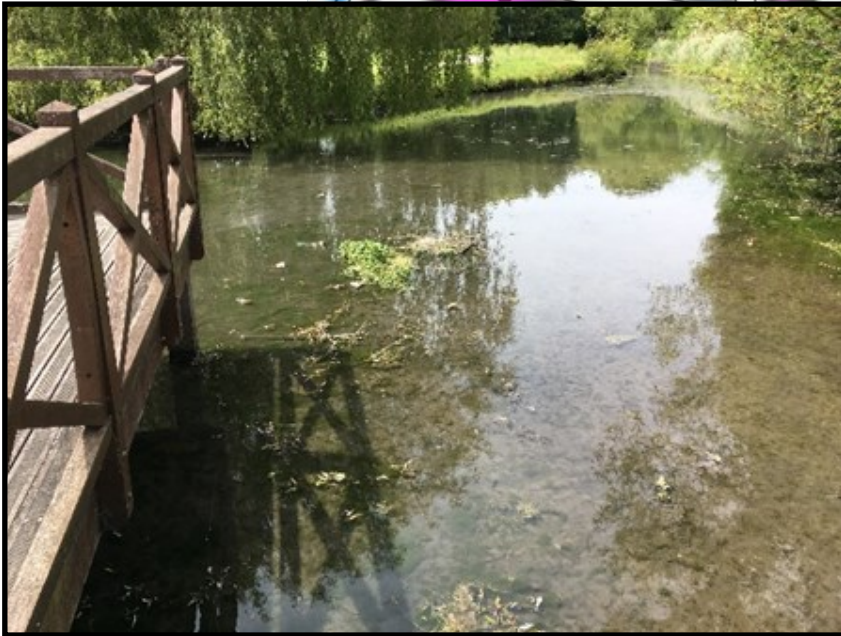
Avant intervention sur l'aval
