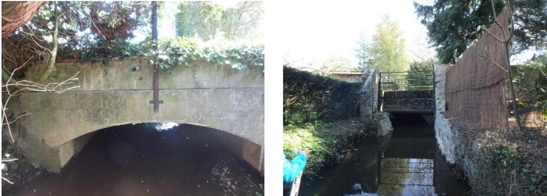
Figure 137 Photos de ponts impactant l'écoulement de la Guesle (printemps 2017)
