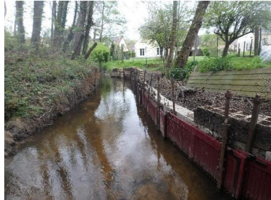
Figure 99 Photo d'enrochements libres sur la Drouette (printemps 2017) et photo de protection de fortune sur la Guesle (printemps 2017)
